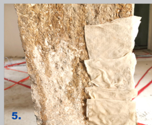
slika 5 čišćenje - otapanje skrama nanošenjem pulpe s otopinom amonij karbonata
