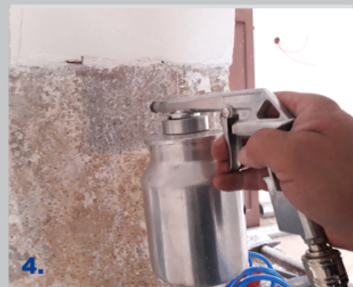
slika 4 abrazivno čišćenje nečistoća i slojeva naliča metodom suhog pjeskarenja
