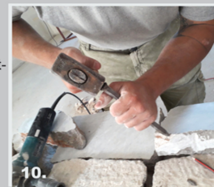
slike 10 i 11 detalj izrade tašela i površinska obrada kao na originalnim pločama
