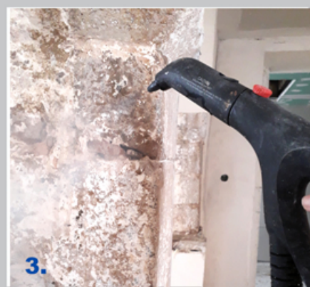
slika 3 proba čišćenja omekšavanjem tvrdokornih skrama parnim čistačem
