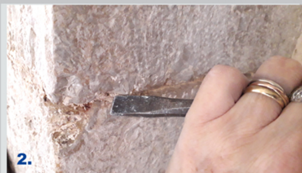
slika 1 i 2 sonda sa probom čišćenja, ručno čišćenje sljubnica
