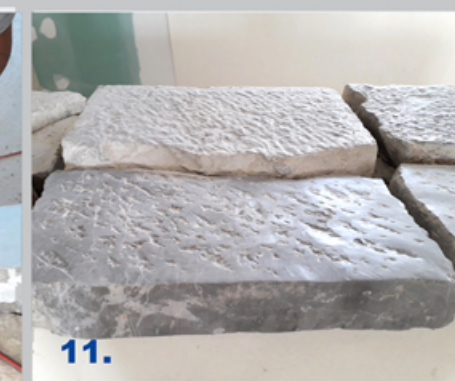
slike 10 i 11 detalj izrade tašela i površinska obrada kao na originalnim pločama
